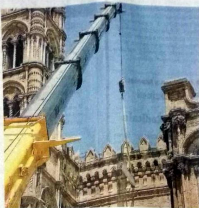
Le difficili operazioni per introdurre le travi nel sottotetto della Cattedrale
